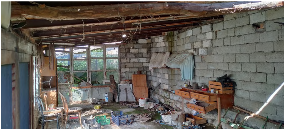
Foto lotto n. 9- magazzino – nei disegni stato attuale
