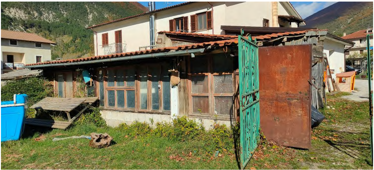
Foto lotto n. 9- magazzino – nei disegni stato attuale
