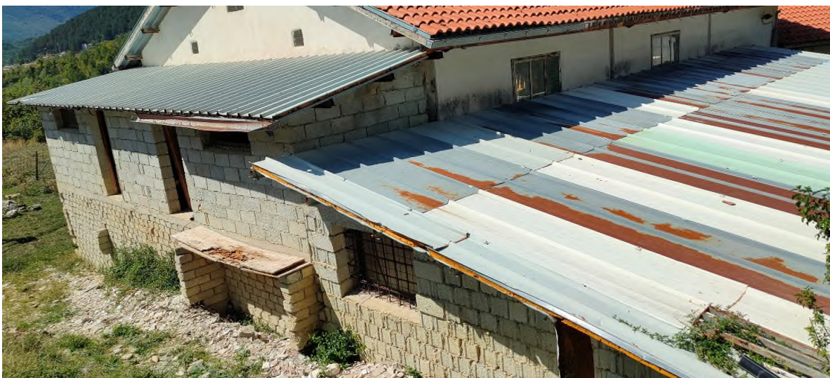
Foto lotto n. 10- magazzini n.5-6-7-8 e stalla n.2– nei disegni stato attuale
