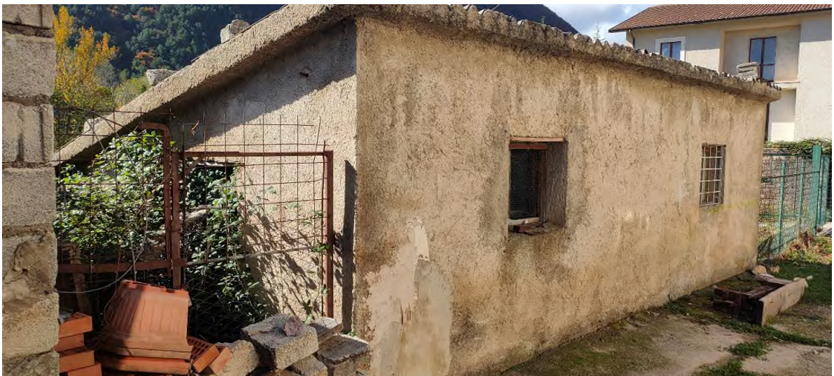
Foto lotto n. 9- magazzino o pollaio – nei disegni stato attuale
